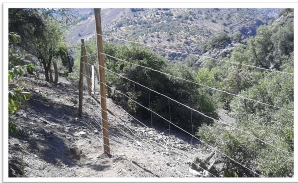
Figura N°8. Reparaciones de cerco. Tensado de malla.
